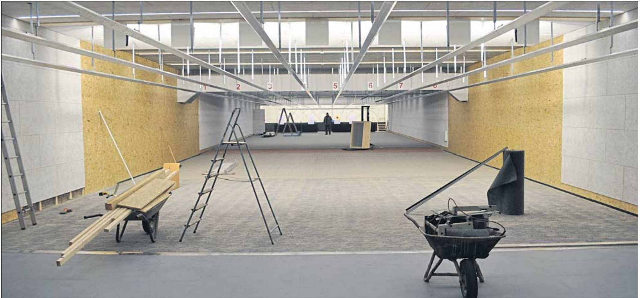
Beindruckend: Letzte Kleinigkeiten müssen vor der Abnahme des 50-Meter-Schießstandes noch fertiggestellt werden, dann können die Gersfelder Schützen hier wieder mit Pistole und Gewehr schießen. Fotos: Sebastian Dänner
